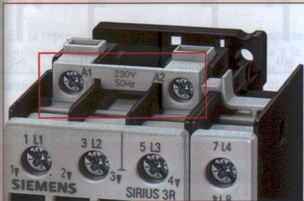
Figura 11.4. Contactos A1-A2 de la bobina.
