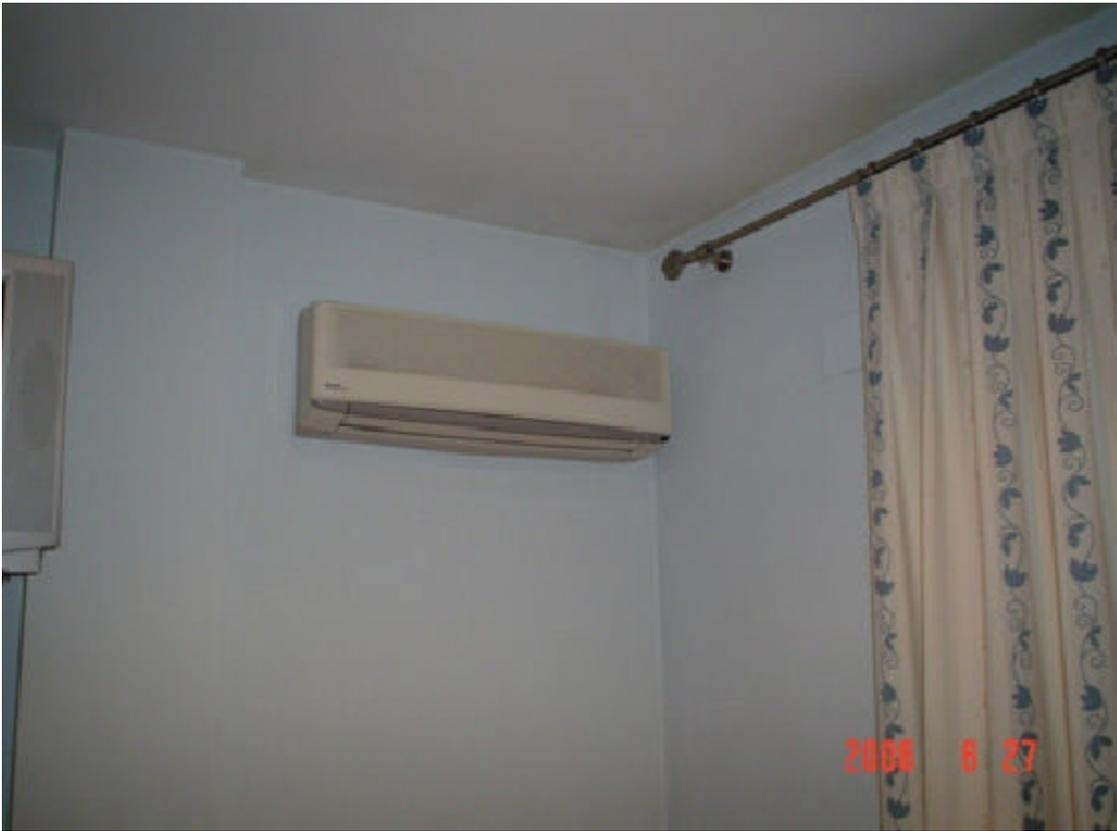
El aire acondicionado doméstico funciona con energía eléctrica. La potencia absorbida de la red eléctrica por un equipo de aire acondicionado varia entre 1 kW y 7 kW, dependiendo de las necesidades de refrigeración y calefacción de la vivienda.
